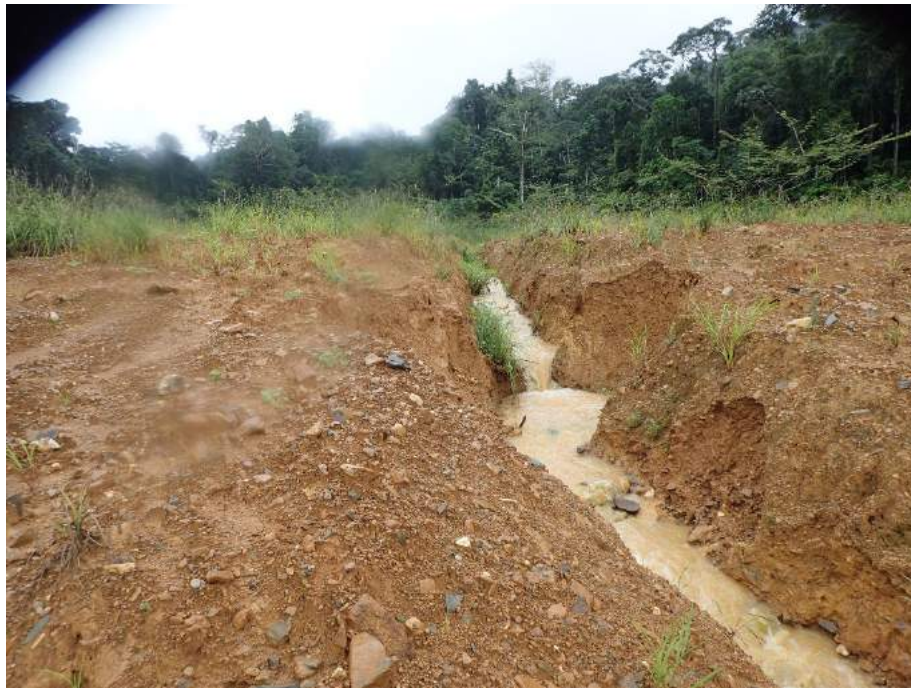
Figure 58 : Vue de l'eau turbide arrivant de l'amont de la zone C: Photo au centre de la zone C.
