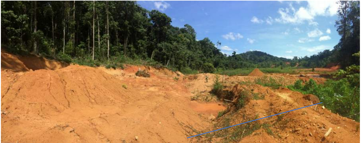
Figure 17 : 11/2016 : Zone A : La petite fosse (cf. figure du dessus) en pied de mont va être comblée, les fronts stabilisés sécurisés
