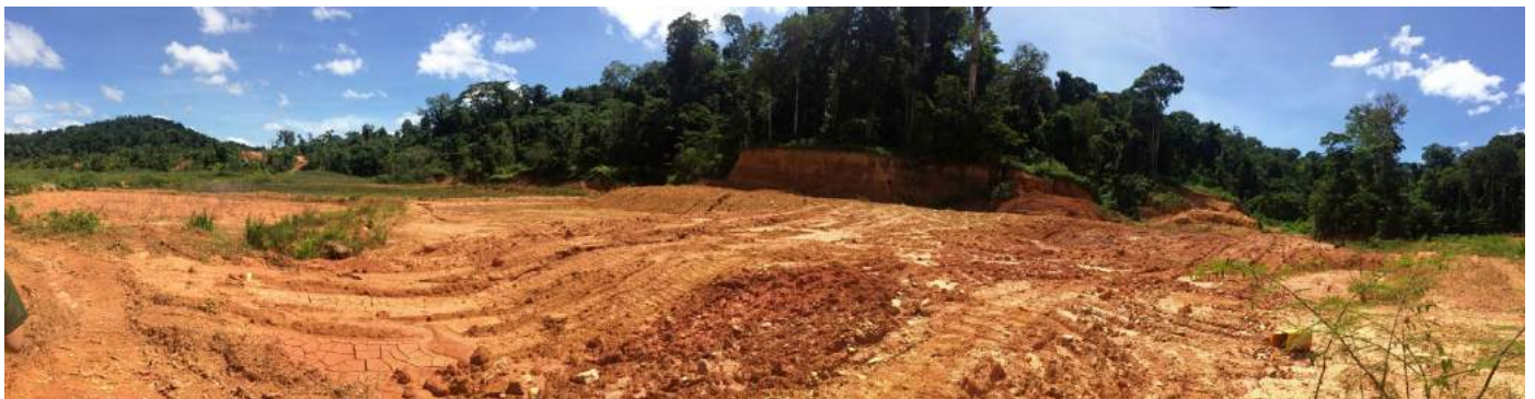
Figure 18 : Vue vers le relief sud zone B : terrassements achevés.
