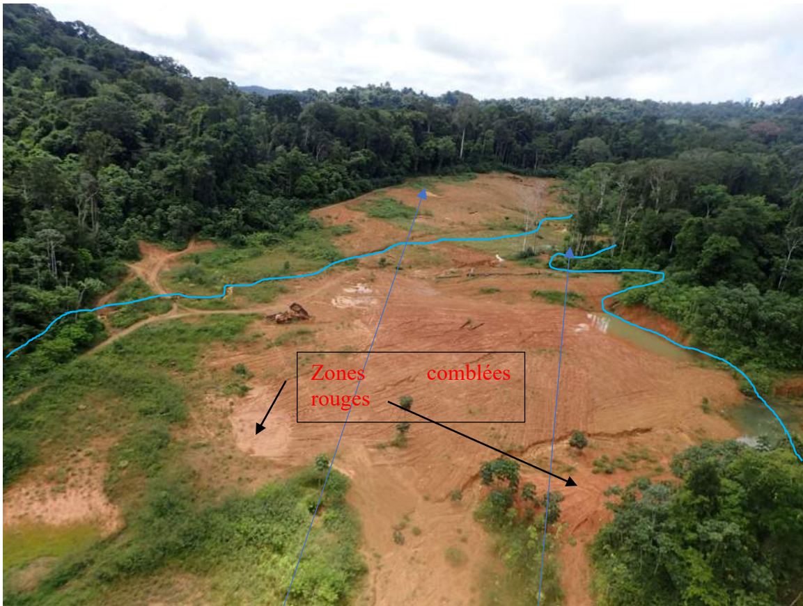
Figure 38 : Zone C le 18/05/2020 vue de l'aval vers l'amont.
