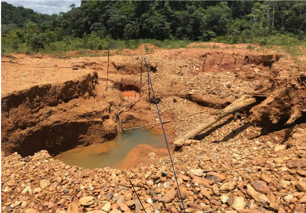
Figure 29 : IMG 2460 : Nouveau chantier illégal ; Zone C
