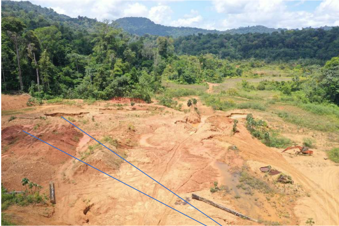
Figure 37 : DJI 96 : Zoom sur la partie à terrasser ouest.
