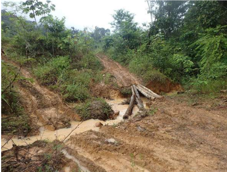
Figure 59 : Mesure N°1 aval de la zone C.574 NTU - eau très turbide.
