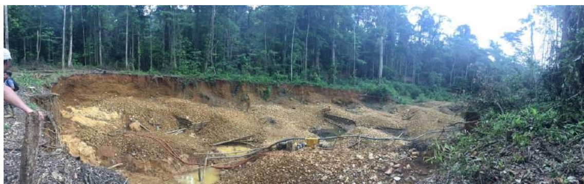
Figure 54 : Etat de la zone C aval avant exploitation par AOTM, chantiers illégaux en activité.
