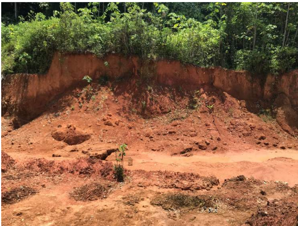
Figure 28 : IMG 2459 front de taille en cours de reprofilage, zone C, 10/2019;
